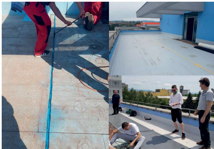
Obrázok č. 4 – realizácia testovacích segmentov experimentálnej vegetačnej strechy.
