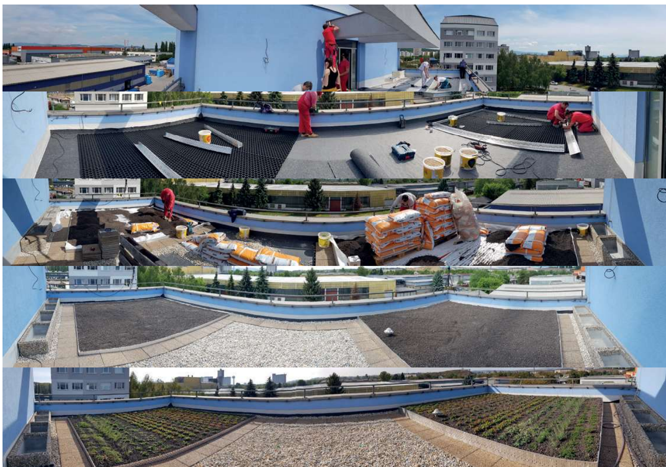
Obrázok č. 5 – realizácia experimentálnej vegetačnej strechy v obrázkoch.
